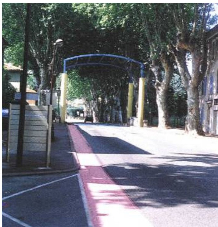
porta di ingresso al centro di Piolenc (Francia) segnalata con elementi di arredo urbano e combinata con banchine transitabili al ciclo
